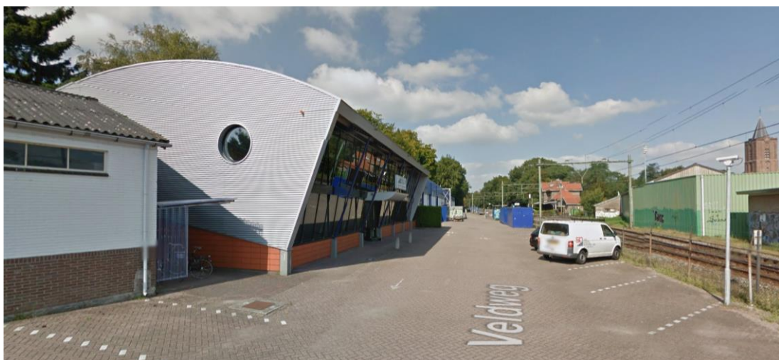
Bedrijfsbebouwing en buitenterrein op het perceel Veldweg 2b
