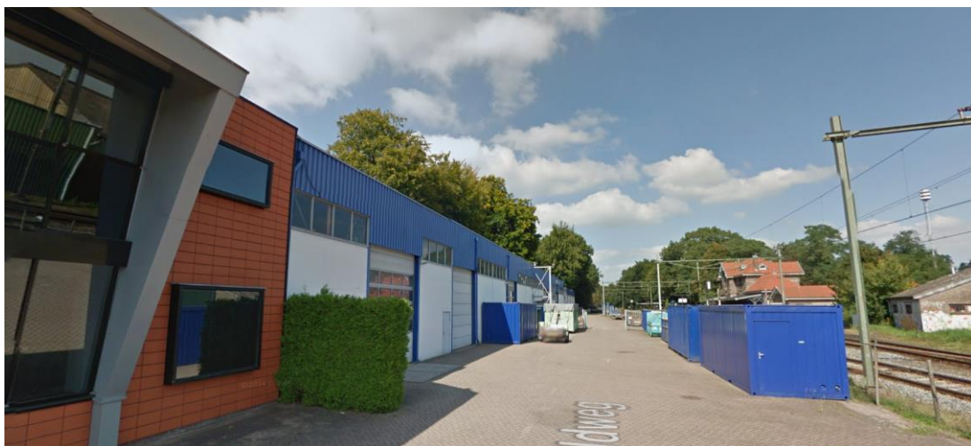
Bedrijfsbebouwing en buitenterrein op het perceel Veldweg 2b
