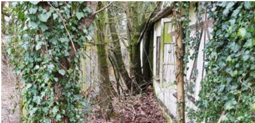
Foto 8. Boom 11 en 12 (meerstammig) zijn tegen de gevel gegroeid. Bij de sloop van dit gebouw zijn deze bomen niet te behouden.
